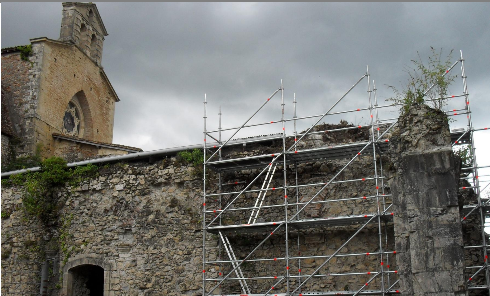
Monastère de Sorde en travaux © Commune de Sorde l'Abbaye
