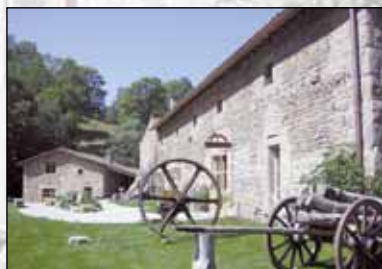
Moulin des Massons, Saint-Bonnet-le-Coureau (Loire).
