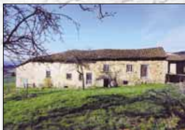
Ancienne ferme, Cublize (Rhône).
