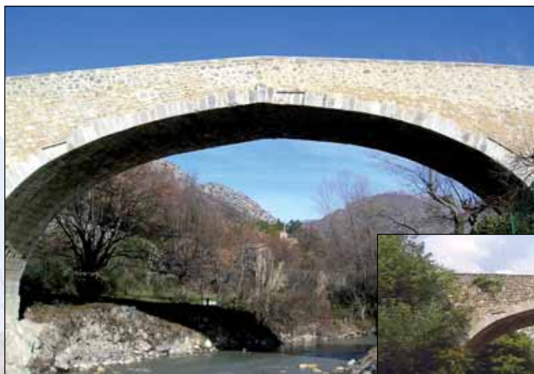
Pont, après et avant restauration, Buis-Les-Baronnies (Drôme).
