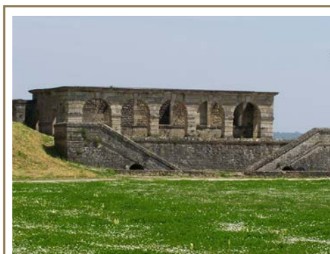
Corps de garde avant restauration © Commune de Cussac-Fort-Médoc
