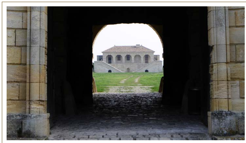
Corps de garde après restauration © Commune de Cussac-Fort-Médoc
