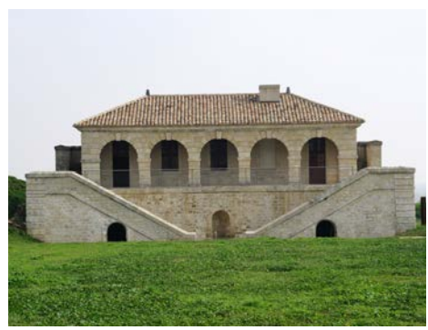
Corps de garde après restauration © Commune de Cussac-Fort-Médoc
