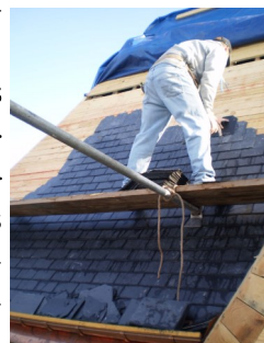
Pose d'ardoises au clou, Setques
