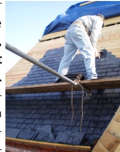
Pose d'ardoises au clou, Setques
