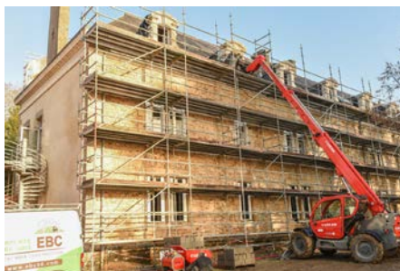
Restauration des façades avec enduit traditionnel à la chaux
