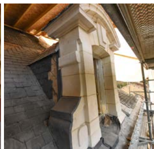
Création de lucarnes en pierre de taille identiques aux existantes
