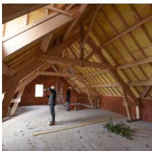
Réfection des charpentes, des couvertures et des isolations
