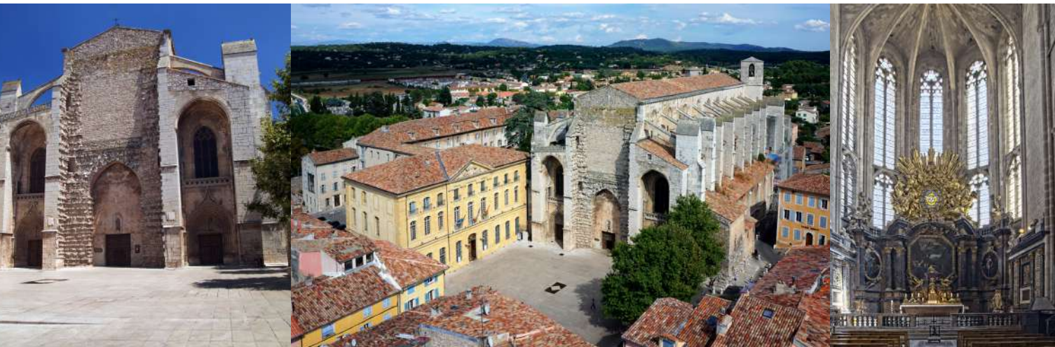
Credit photos © Fondation du patrimoine
