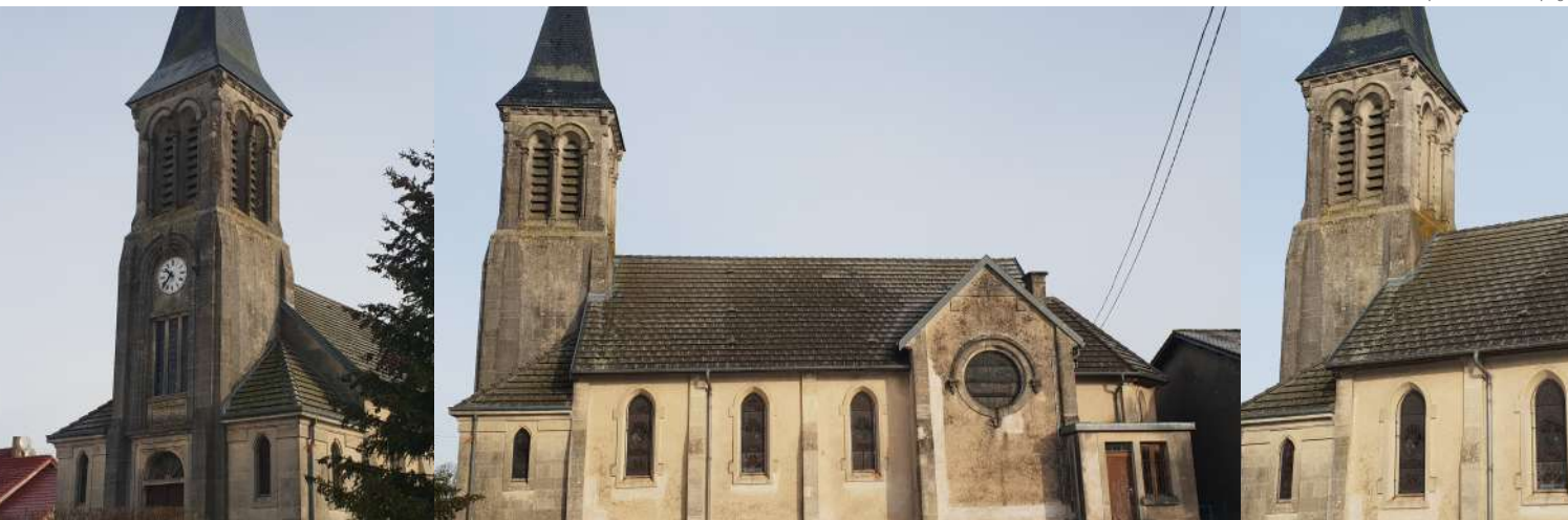
Credit photos © Mairie des Eparges
