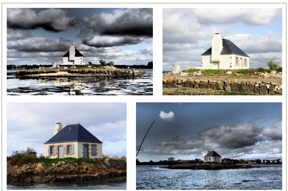
Maison du gardien de l'île du Nohic APRÈS restauration © Mairie de Plouhinec
