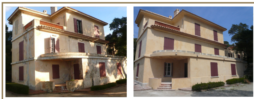
Le Rayolet avant et après rénovation © Fondation du patrimoine
