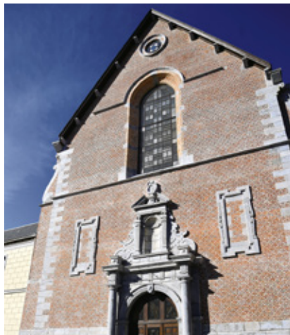
Façade © Ville de Maubeuge
