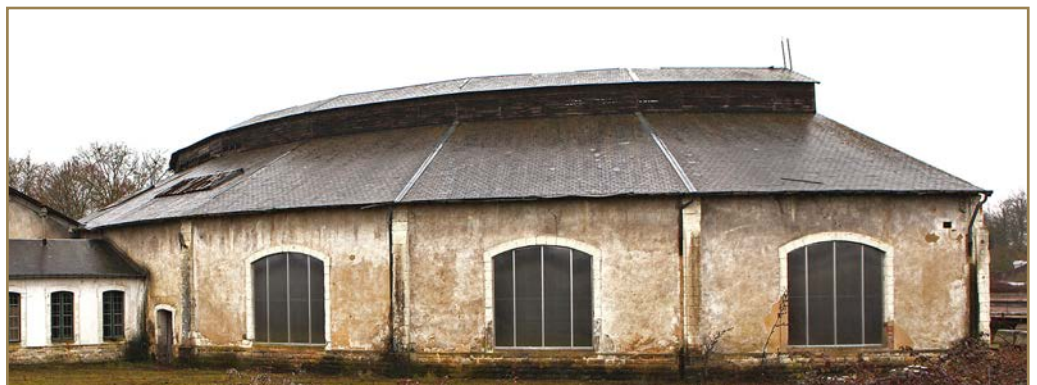
Vue des accès extérieurs de la rotonde ferroviaire de Montabon AVANT et APRES restauration des baies © RFVL
