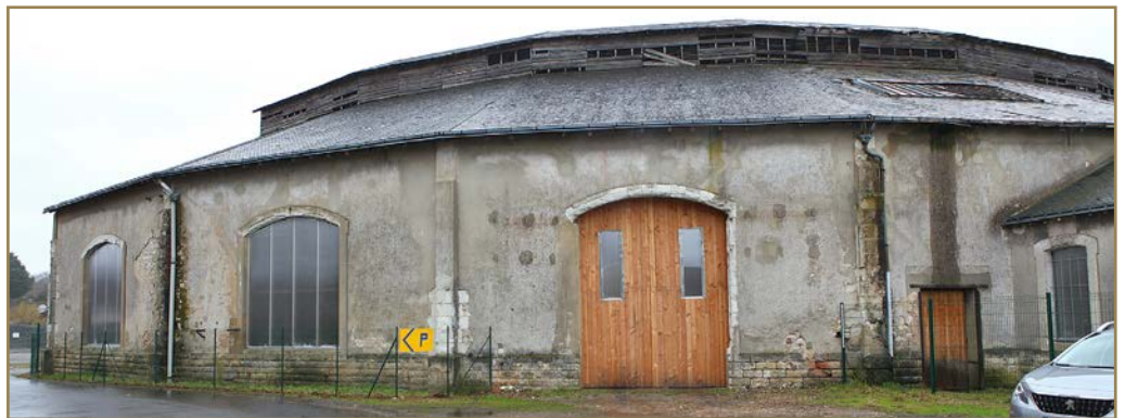
Accès arrière de la rotonde ferroviaire de Montabon AVANT et APRES restauration d'une porte © RFVL
