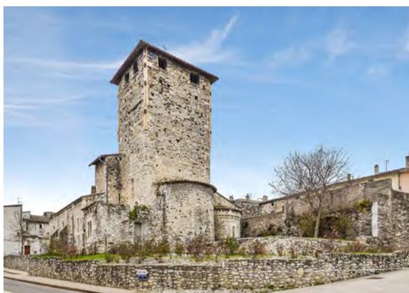
Eglise Saint-Etienne de Mélas au Teil © OCUS-Fondation du patrimoine
