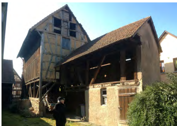
Avant démontage : séchoir à tabac de Lipsheim © Dominique Tomasini
